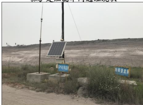
现有二期库区上游坝
