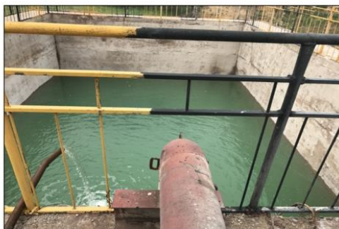
现有二期库区上游回水池
