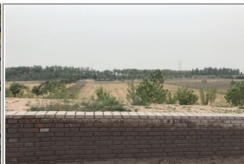
已闭库的一期赤泥库
