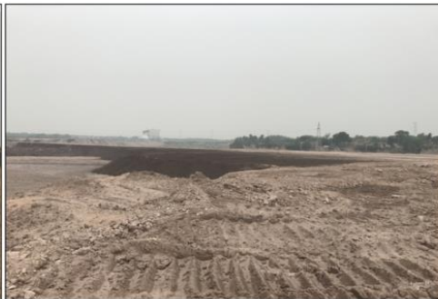
现有二期加高库区现状
