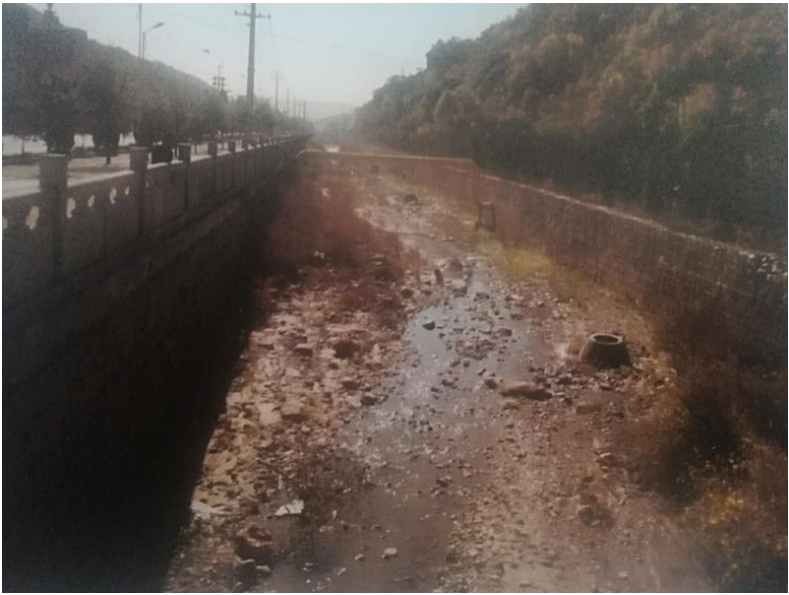
图 2.3-11 城区段已建浆砌石堤防
