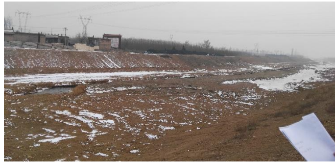
图 2.3-16 禹门河北廓村下游现状
