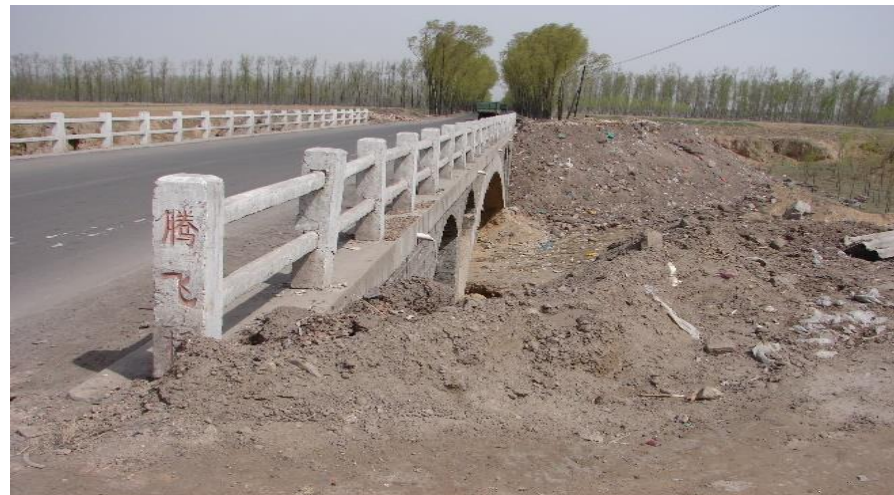
图 2.3-17 禹门河腾飞桥现状
