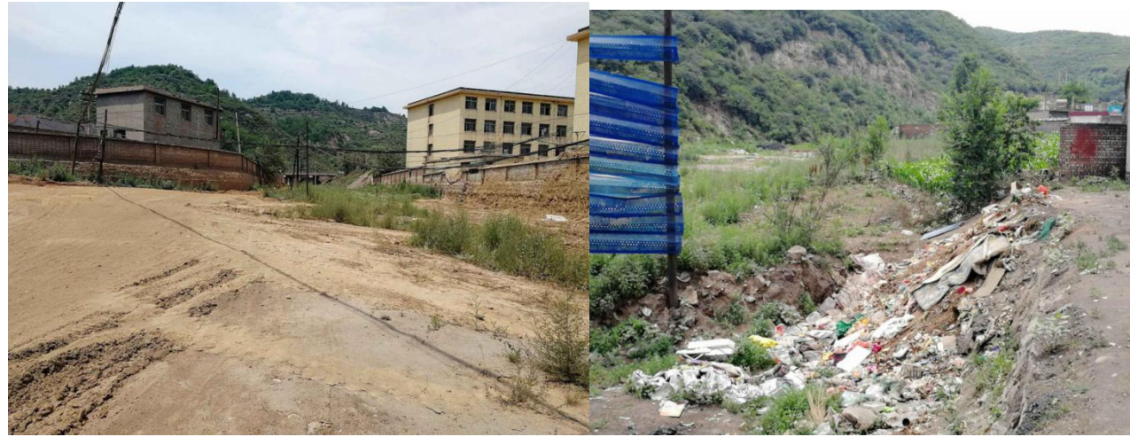
图 2.3-12 现状河道浆砌石堤防图
