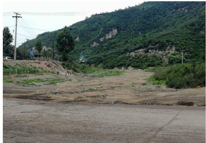
图 2.3-14 河道内堤防缺失
