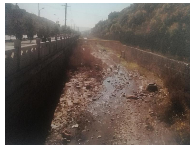
图 2.3-11 城区段已建浆砌石堤防
