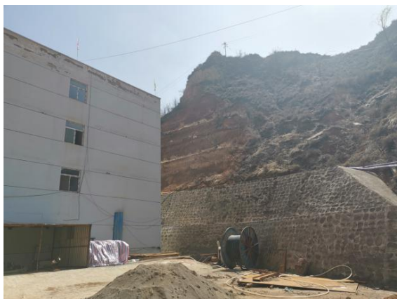
照片 8-2-3 W2 已治理边坡现状（镜向 SW）
