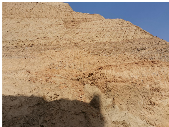
照片 8-2-2 W1 未治理边坡现状(镜向 N)
