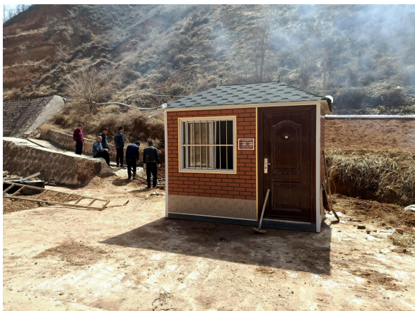
照片 8-2-19 地埋式生活污水处理站
