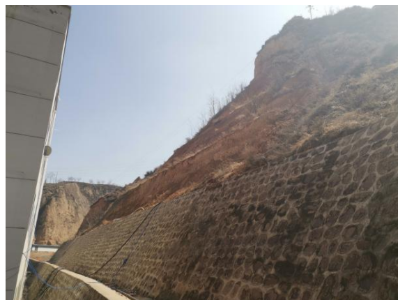
照片 8-2-4 W2 已治理边坡现状（镜向 ES）
