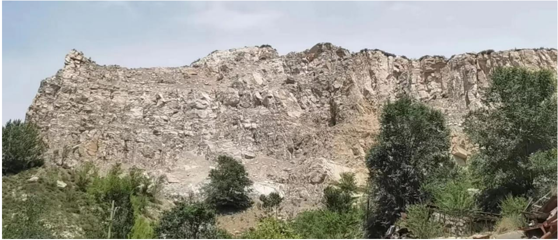
照片 8-2-1 露天采场不稳定斜坡（BP1）
