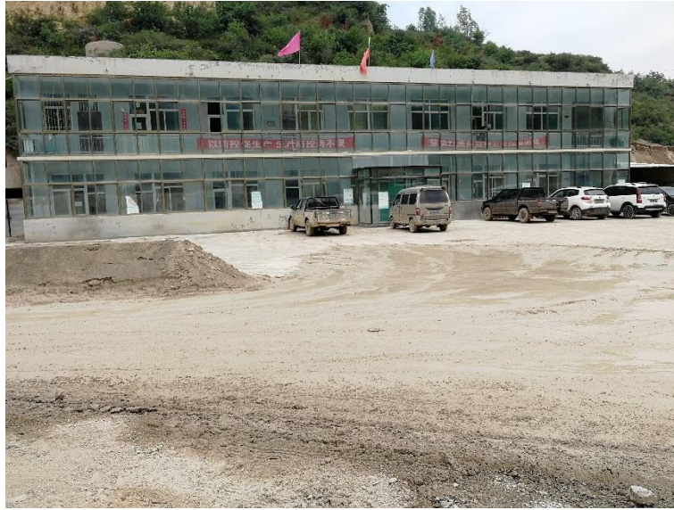
照片 8-2-2 工业场地办公楼
