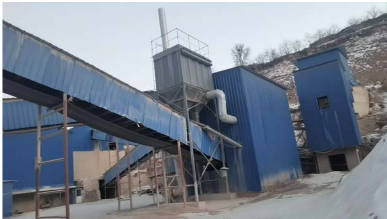
照片 8-2-18 除尘器照片
