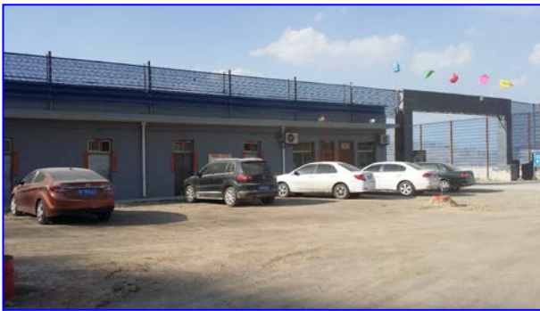
照片 8-2-11 值班室现状（镜向 NW）
