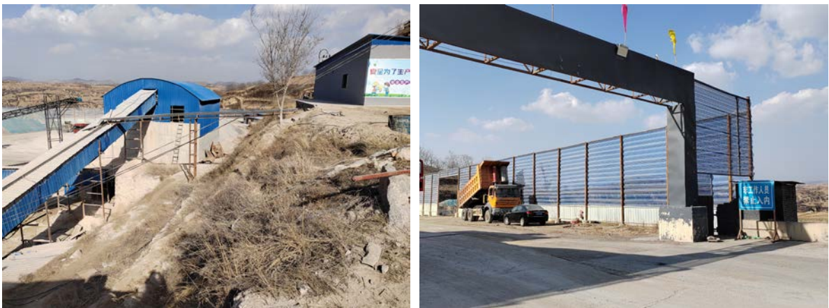
照片 8-2-20 破碎加工场地照片
