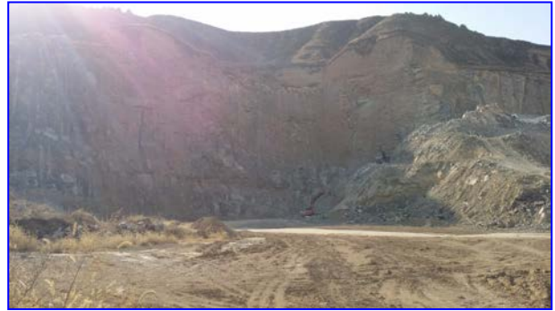
照片8-2-2 W_2 不稳定斜坡（镜向W）
