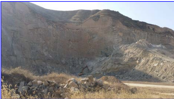
照片8-2-3 N_1 潜在泥石流沟物源（镜向WN）
