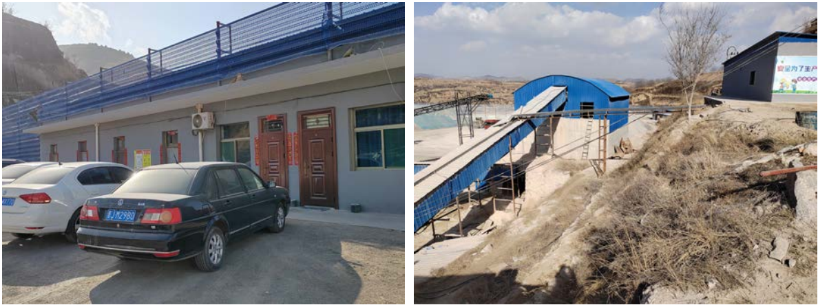
照片 8-2-17 破碎加工场地照片
