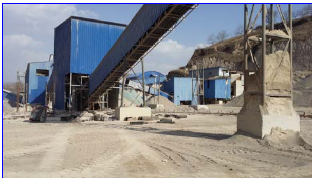
照片8-2-9 破碎加工场地现状（镜向E）
