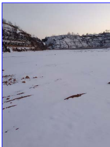
照片 8-2-15 排土场区现状（镜向 N）
