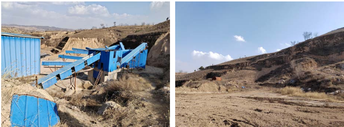
照片 8-2-18 废弃采矿用地
