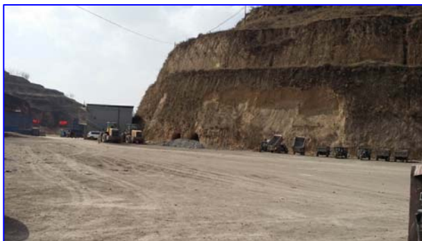
照片 8-2-5 W_1 不稳定斜坡(镜向 WS)
