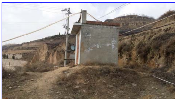
照片 8-2-17 南岭村供水深井(镜向 WS)
