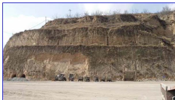
照片 8-2-6 W_1 不稳定斜坡坡顶(镜向 WN)
