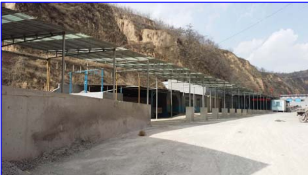
照片 8-2-21 工业场地中部地形地貌景观(镜向 N)
