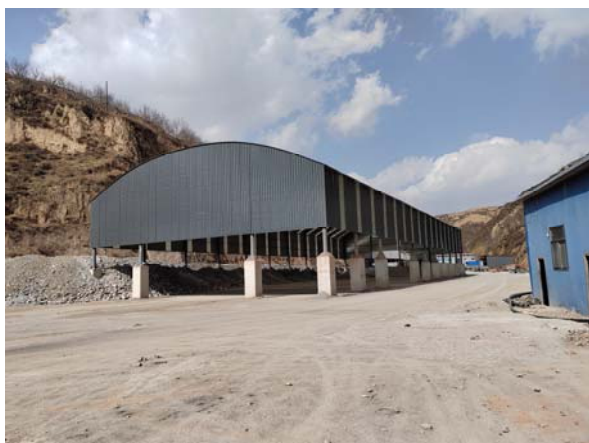
照片 8-2-36 封闭式储料棚（正在建设）
