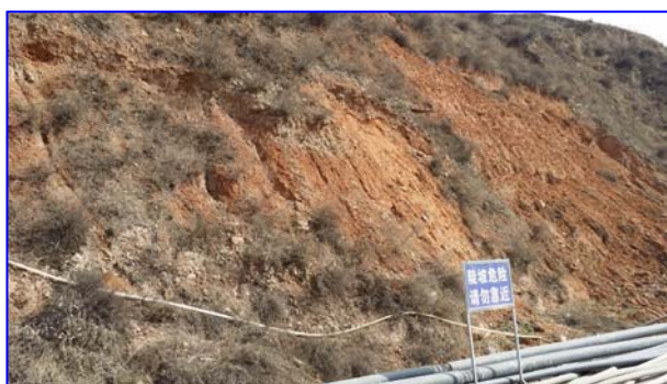
照片 8-2-8 W_2 不稳定斜坡(镜向 ES)
