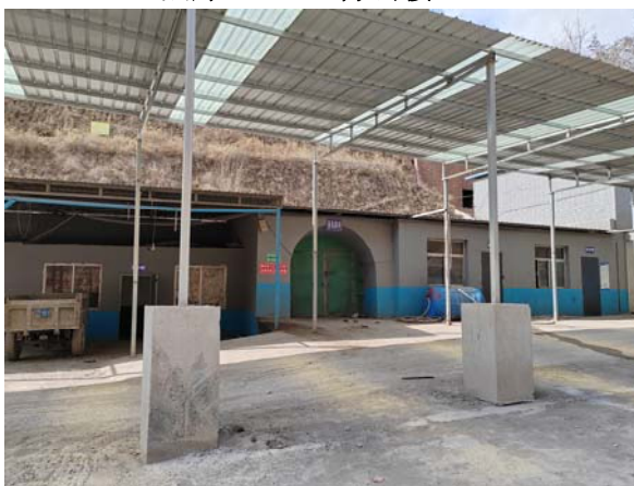
照片 8-2-31 回风斜井井口
