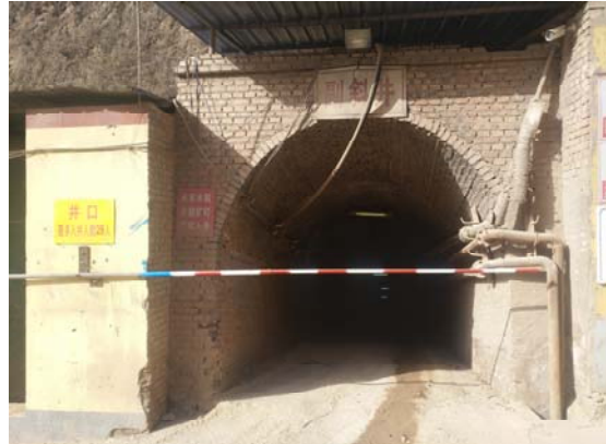
照片 3-2-2 副斜井（镜像西）
