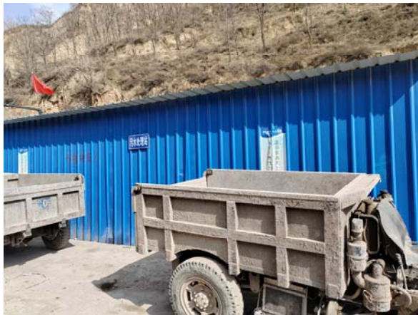
照片 8-2-38 地埋式生活污水处理站
