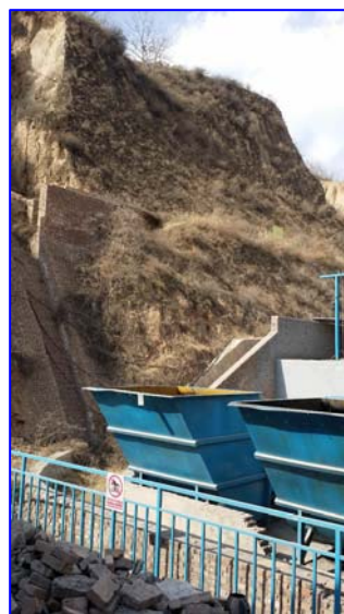
照片 8-2-3 XP_1 已建截排水沟（渠）(镜向 NNE) 照片 8-2-4 XP_1 已建护堤及排水沟(镜向 NW)
