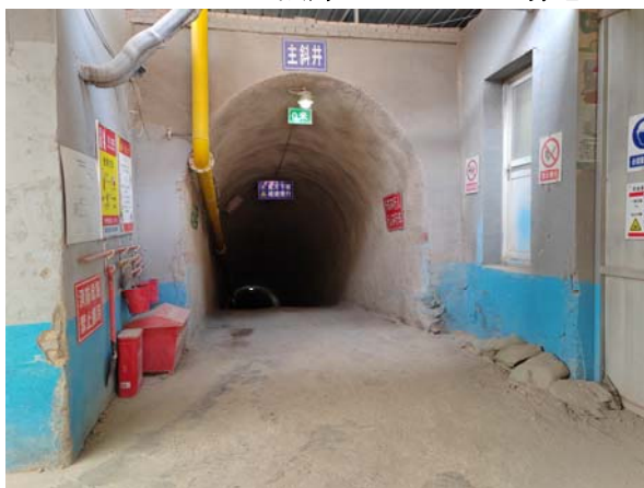
照片 8-2-30 主斜井井口
