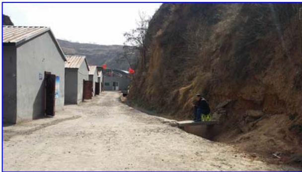
照片 8-2-10 W_3 不稳定斜坡(镜向 NE)
