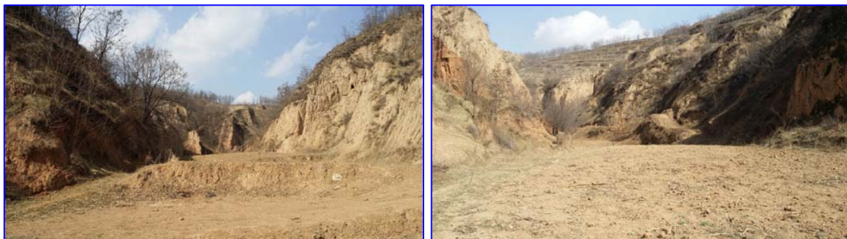
照片 8-2-15 N 2 潜在泥石流沟现状(镜向 NW) 照片 8-2-16 N 2 潜在泥石流沟现状(镜向 NE)
