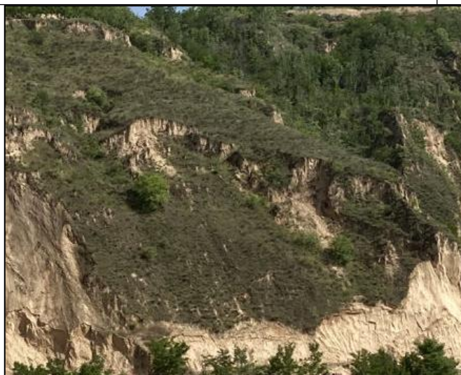
照片 8-3-1 取土场现状
