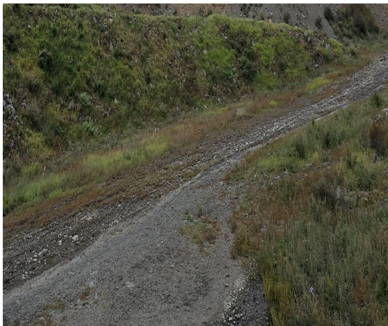
照片 2-2-3 矿区道路
