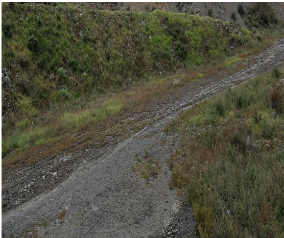
照片 8-2-5 矿区道路
