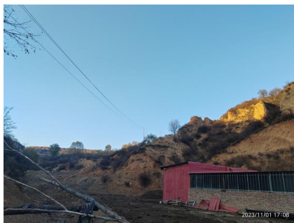
照片 8-2-13 原主井井口处现状
