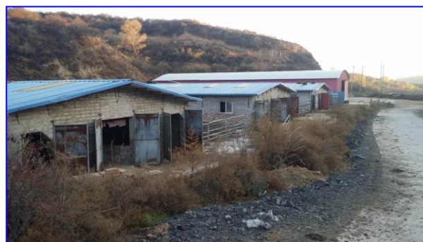
照片 8-2-10 废弃场地地貌景观(镜向 SE)
