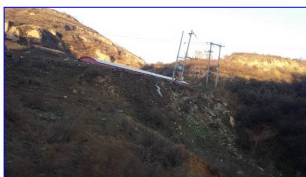
照片 8-2-4 N 1 潜在泥石流沟现状(镜向 EN)
