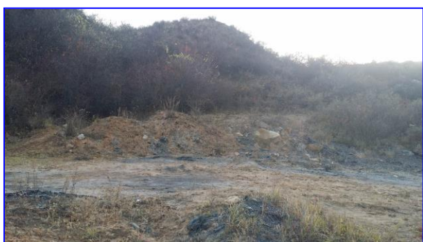
照片 8-2-3 N 1 潜在泥石流沟现状(镜向 WN)
