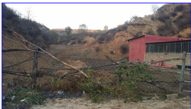
照片 8-2-9 废弃主斜井场地地貌景观(镜向 NW)
