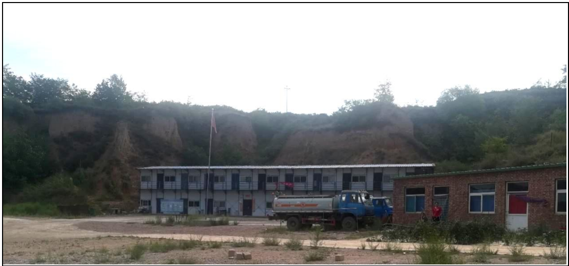
照片 8-2-1-3 W_2 不稳定边坡（镜向 E）
