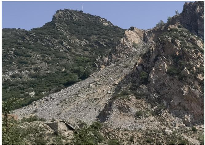
调查访问分布于破碎加工场地北部的部分废弃采矿用地为以往关闭的石英岩料厂及民采破坏形成，现状为开放式露天采场，底部较平坦，标高在 1690-1700m 之间，采场边坡角在 30-35° 之间，局部较陡，现状为裸露岩体，无植被分布，见照片 2-11。总体上矿区范围及周边人类工程活动改变了原有地形地貌景观，人类工程活动较强烈。
