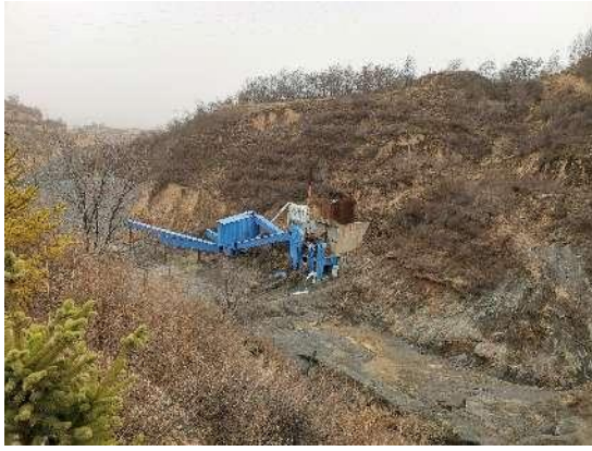
照片 8-2-5 XP3 边坡（镜向 SW）
