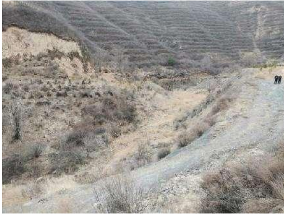
照片 8-2-13 运矿道路（镜向 NW）
