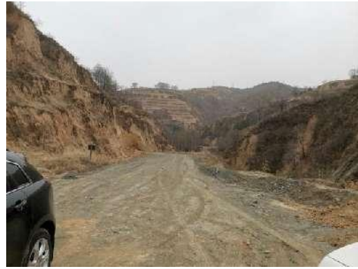
照片 8-2-14 运矿道路（镜向 ES）
