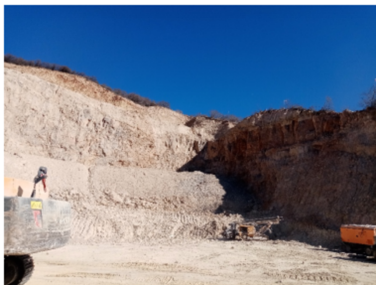
照片 8-1 露天采场北部边坡（镜向北）
