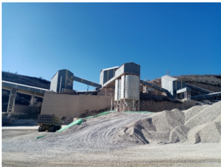
照片 8-2 破碎筛分场地（镜向西）
