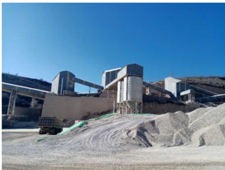
照片 8-6 破碎筛分场地
