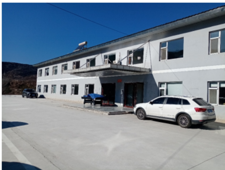
照片 8-3 工业场地办公楼（镜向西北）
