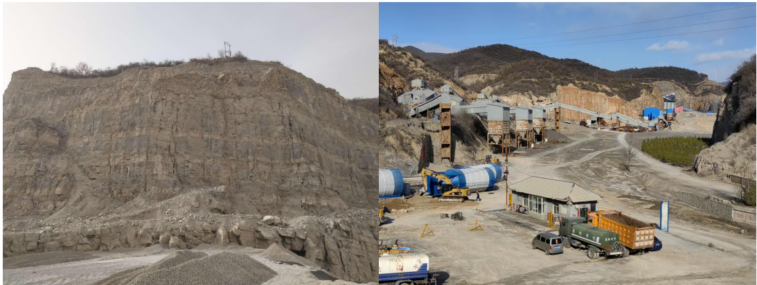
照片 2-1-3-1 采场边坡
