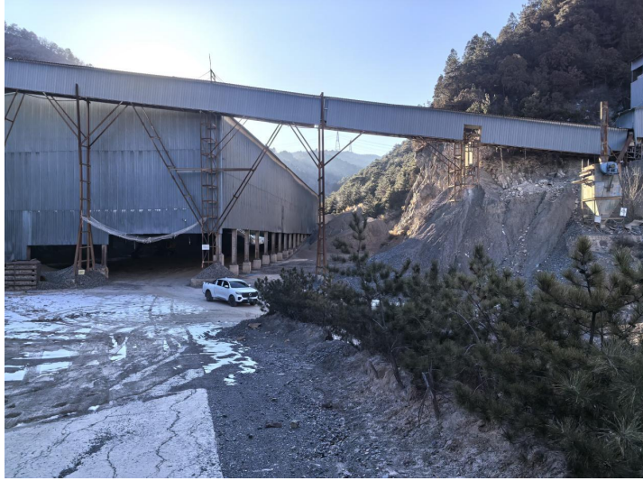
照片 8-2-9 工业场地挖方边坡照片
