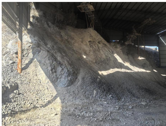
照片 8-2-8 废弃工业场地 2 挖方边坡照片
