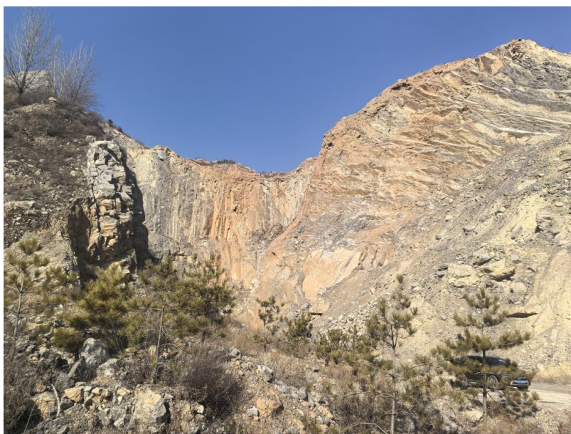
照片 3-1-6 废弃工业场地 3 边坡照片
