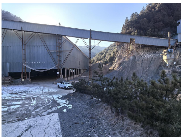
照片 3-1-2 工业场地挖方边坡照片
