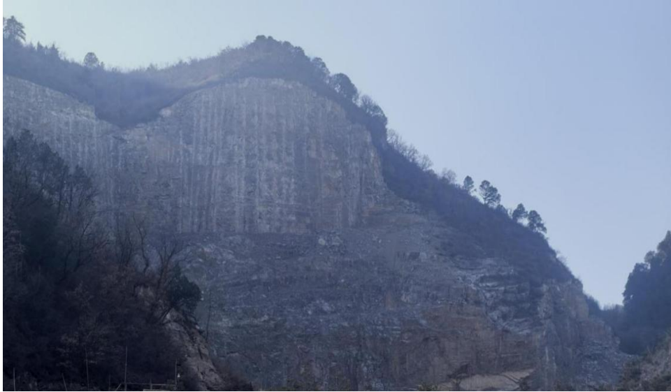
照片 3-1-4 废弃工业场地 1 边坡照片
