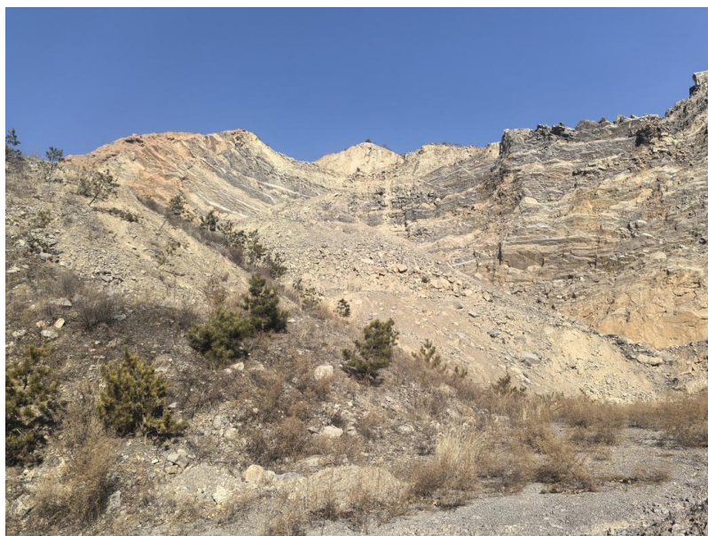
照片 3-1-7 废弃工业场地 4 边坡照片
