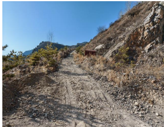
照片 8-2-4 已建矿山道路
