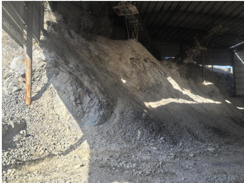
照片 3-1-5 废弃工业场地 2 挖方边坡照片
