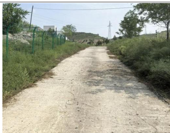
照片 8-2-9 矿区道路照片
