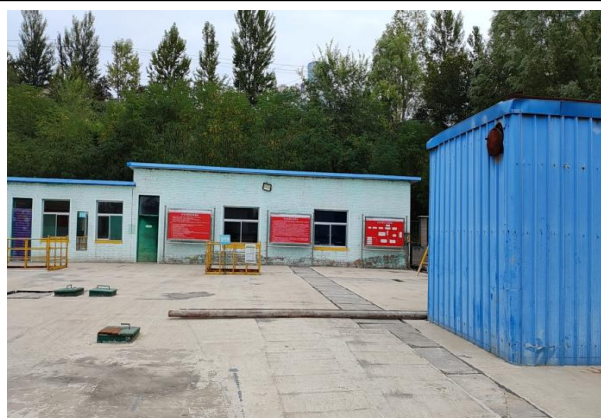
照片 8-2-10 生活污水处理站外观
