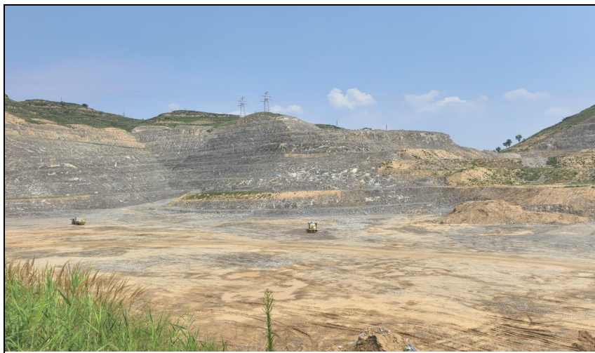
照片 8-2-1 露天采场北部边坡照片
