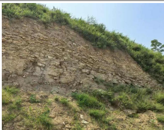
照片 8-2-6 工业场地东南部边坡照片
