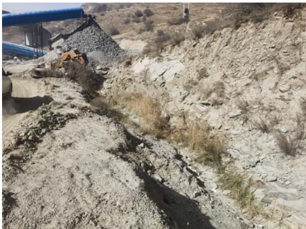
照片 4-1 破碎筛分场地排水渠(镜向东)
