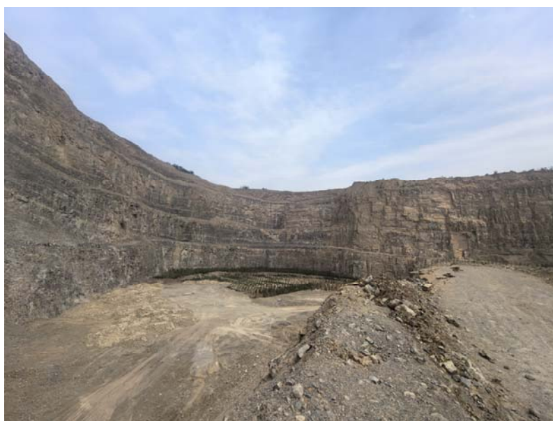
照片 8-2 XP1 不稳定边坡（镜向 NE，2025. 11）
