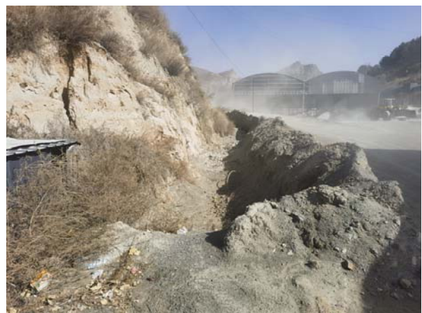
照片 4-2 破碎筛分场地排水渠(镜向东)
