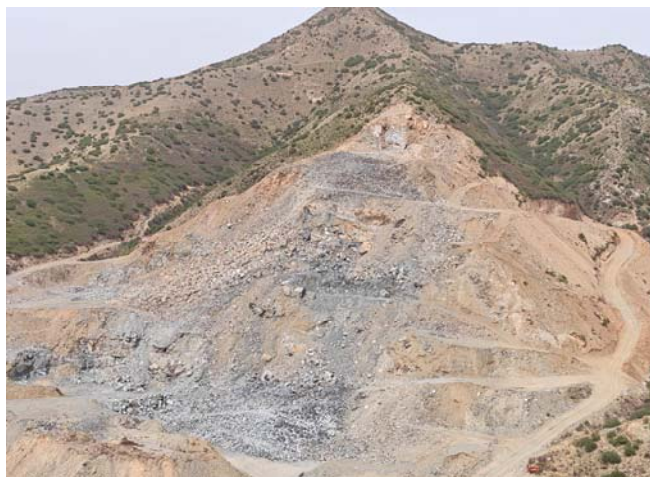
照片 8-1 露天采场 XP1 边坡(镜向北)
