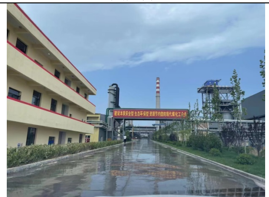
化产西侧道路
