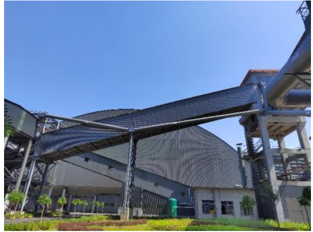
全封闭输焦皮带通廊
