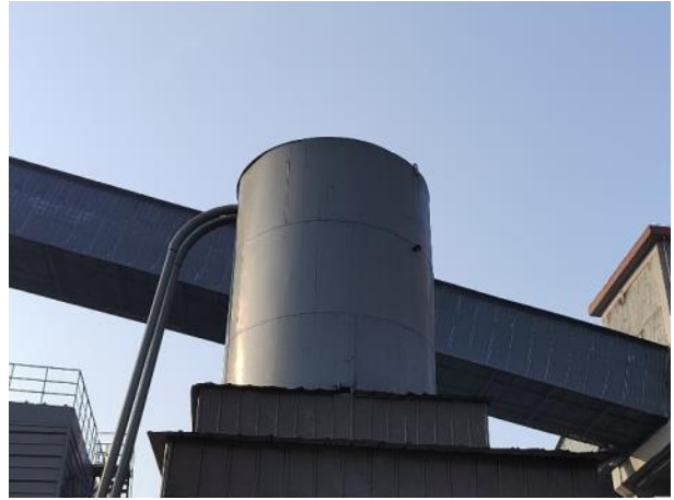
筛焦楼除尘地面站储灰仓
