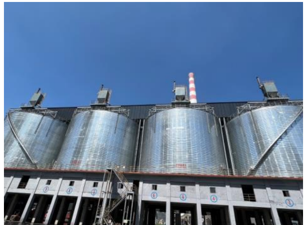
焦仓仓顶 1#2#3#4#袋式除尘器
