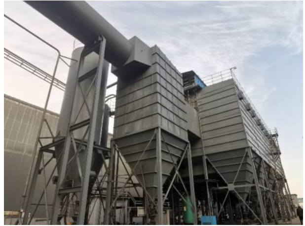
推焦干法脱硫+袋式除尘器
