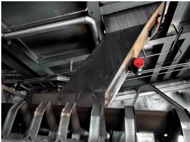
封闭输煤落料点
