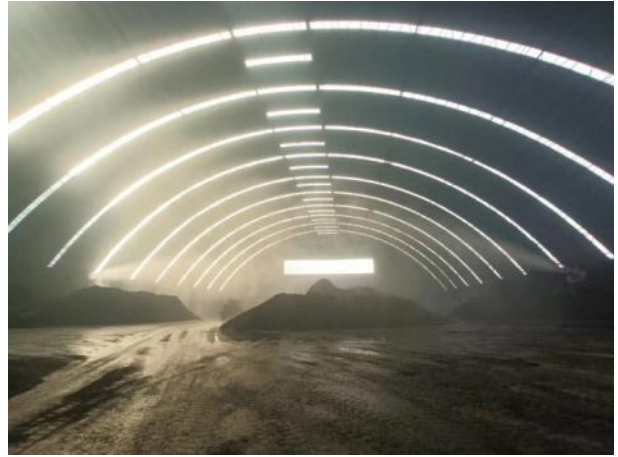
精煤棚内雾炮启动
