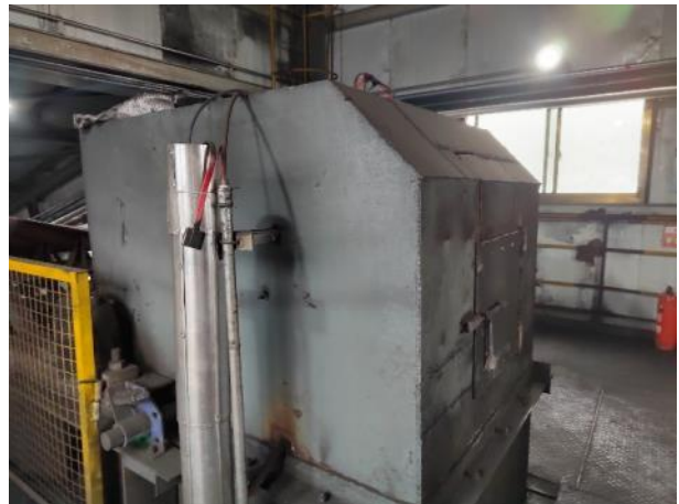
封闭输煤落料点
