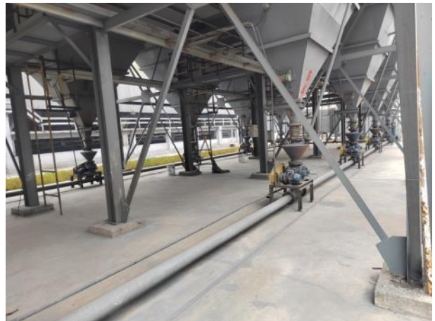
推焦除尘地面站气力输灰装置
