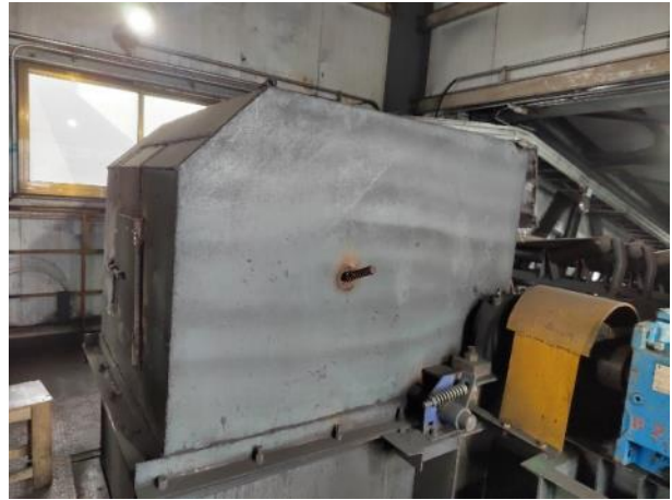
封闭输煤落料点
