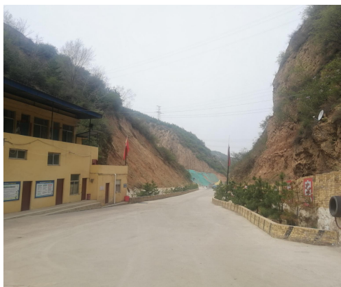
照片 2-3 沟谷 1（镜像西北）
