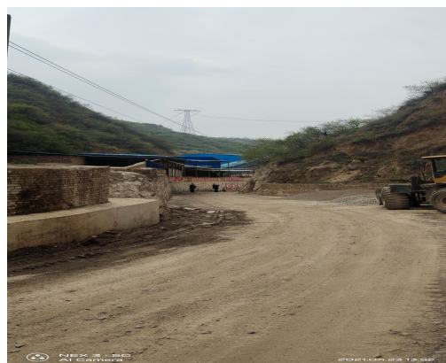
照片 8-6 副斜井场地
