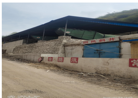
照片 8-7 风井场地
