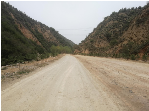
照片 2-7 田间道路（镜像东南）
