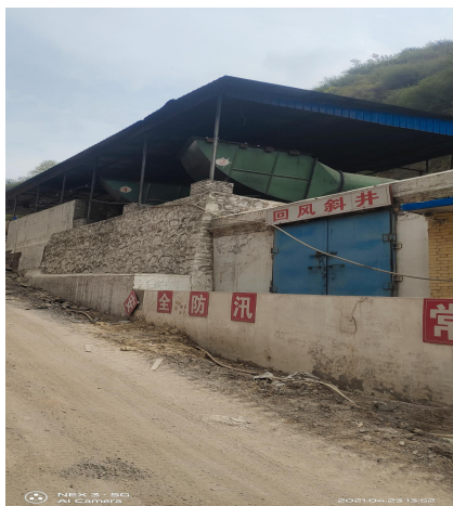
照片 3-1 回风斜井（镜像南）
