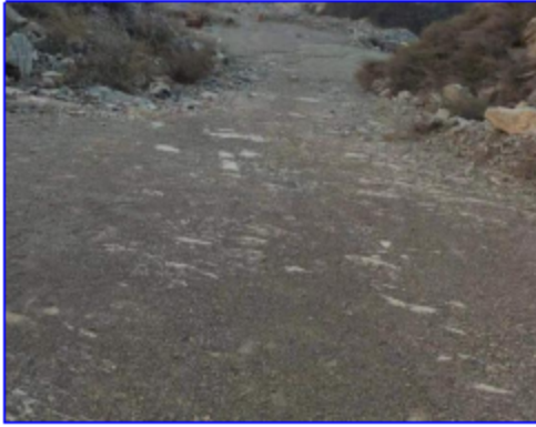
矿区运输道路现状
