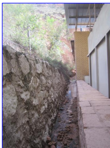
照片 8-2-4 XP 2 已建护堤及排水沟 (镜向 E)
