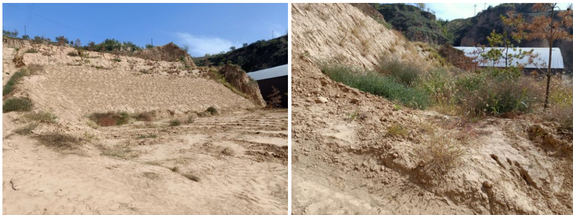
照片 8-2-20 废石场现状
