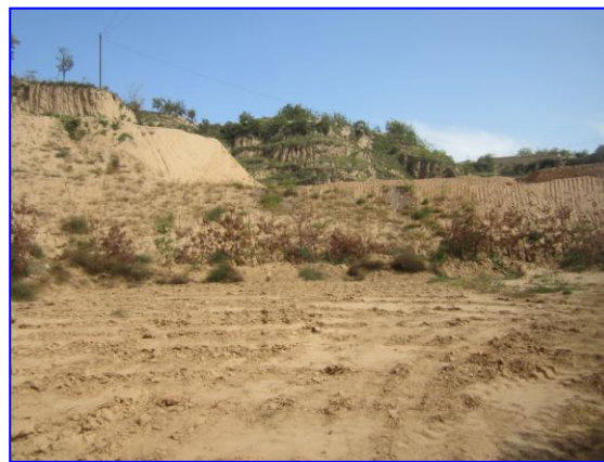
照片 8-2-8 W 1 不稳定边坡坡顶(镜向 E)
