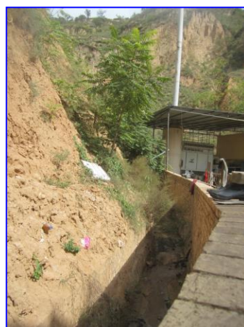
照片 8-2-2 XP 1 已建护堤及排水沟 (镜向 NE)
