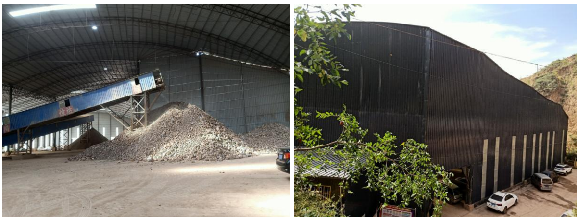
照片 8-2-22 封闭式生产区
