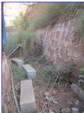
照片 8-2-6 XP 4 已建护堤(镜向 NNW)
