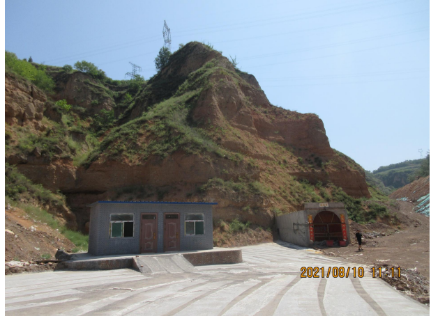
照片 3 副斜井井口 XP3(镜向北东)
