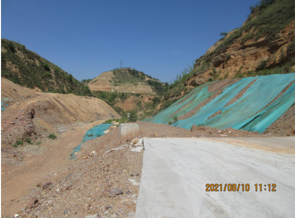
照片 2-4 副斜井场地(镜向西)
