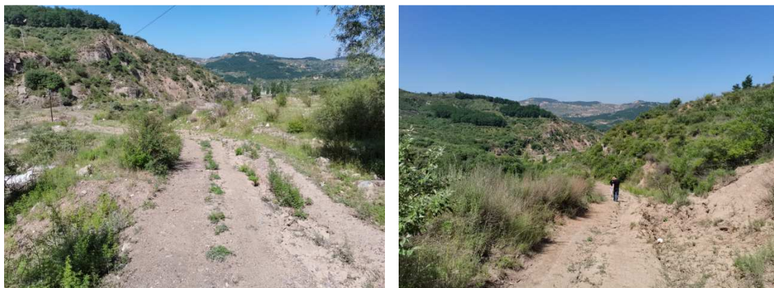
照片 8-2-12 现有道路现状
