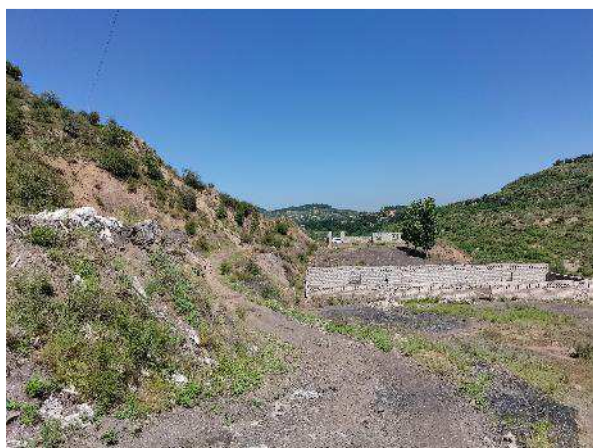
照片 8-2-5 工业场地现状
