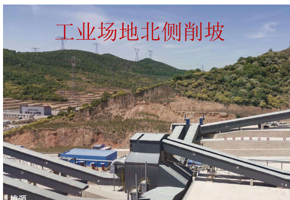
图 1-1 工业场地北侧削坡
