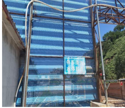
照片 8-2-5-3 喷淋装置
