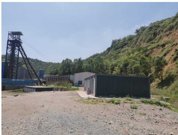
照片 8-2-1 边坡 XP 1 照片（镜向 S）
