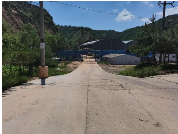
照片 8-2-5-1 场地及道路硬化
