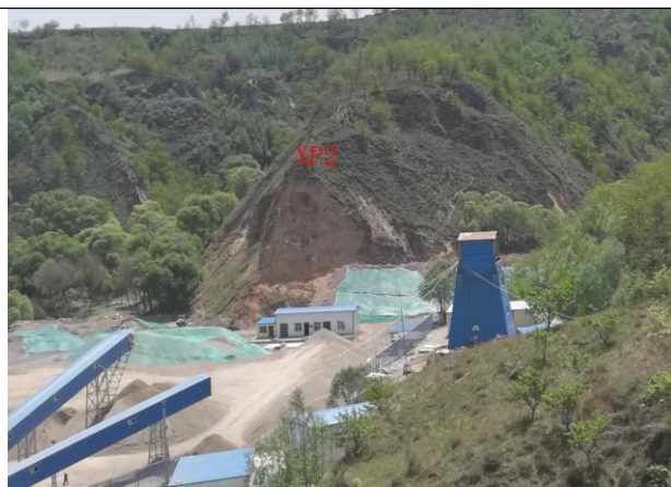
照片 8-2-4 边坡 XP 2 照片（镜向 S）
