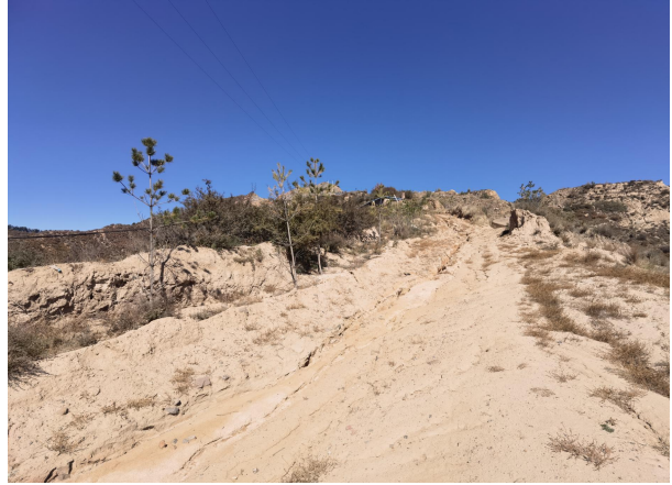
照片 8-5 矿山道路(镜向北)
