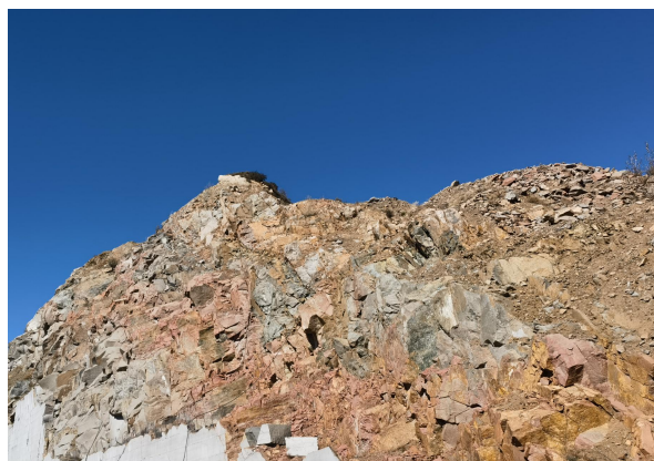
照片 8-1 XP1 不稳定边坡(镜向北西)
