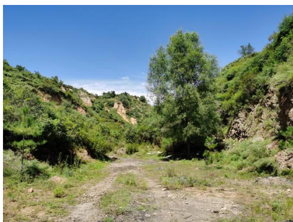
照片 8-2-3 工业场地现状
