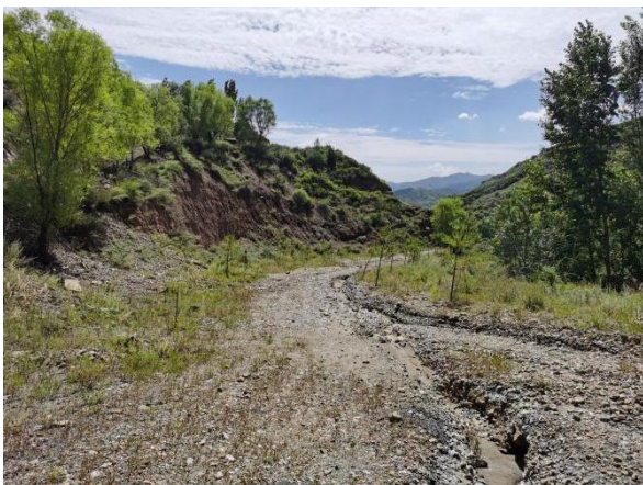
照片 8-2-5 工业场地现状
