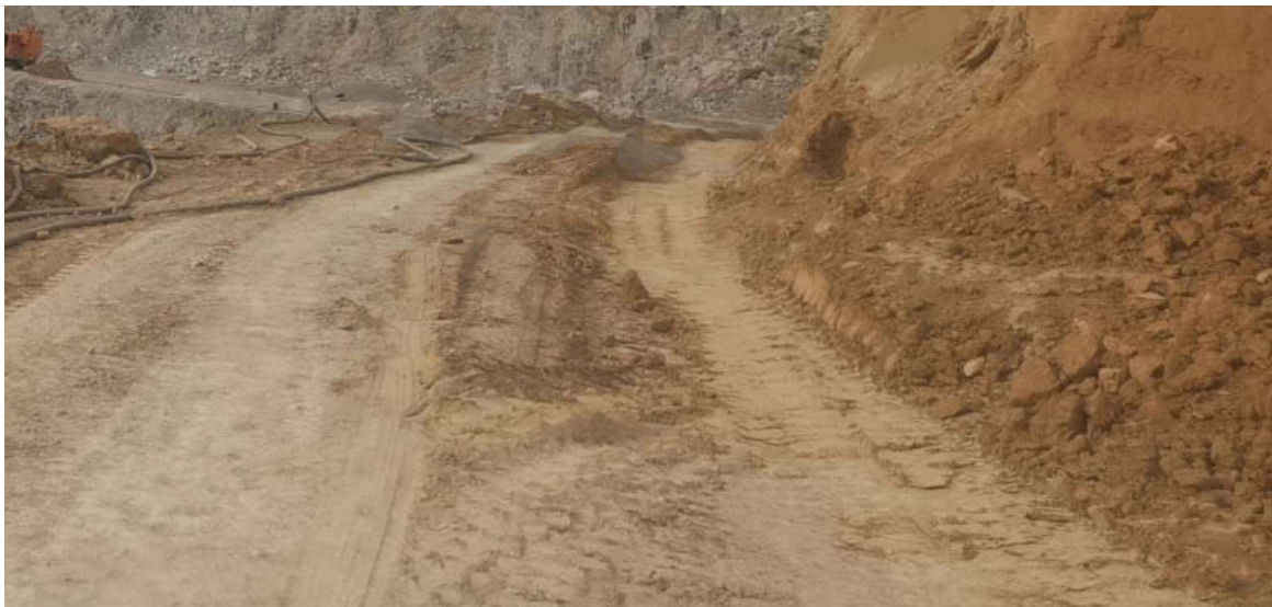
照片 8-2-8 已有道路
