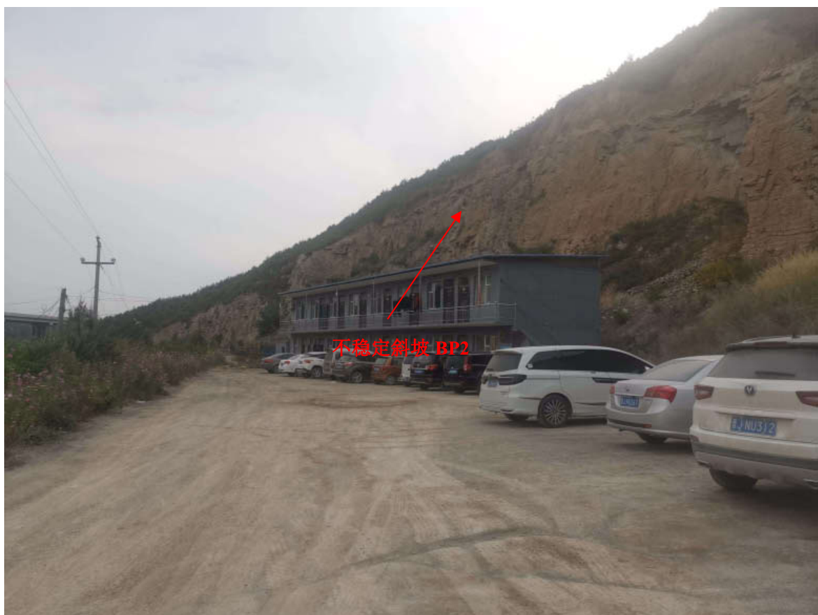
照片 8-2-2 不稳定斜坡 BP2（镜像南）
