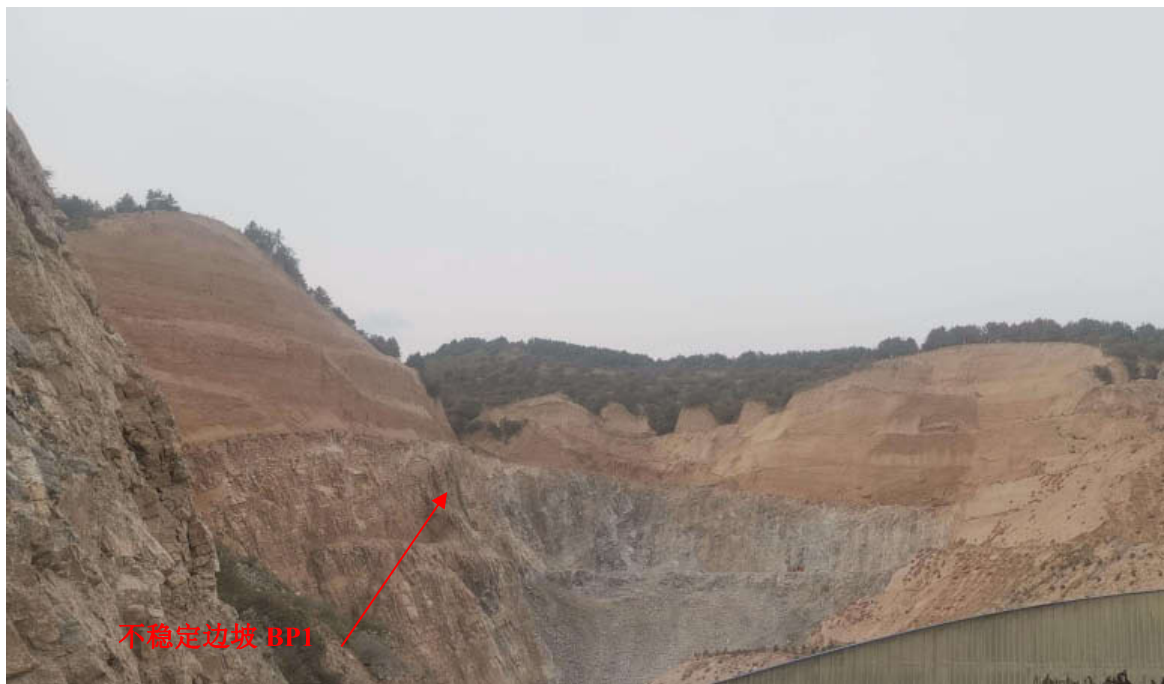
照片 8-2-1 不稳定边坡 BP1
