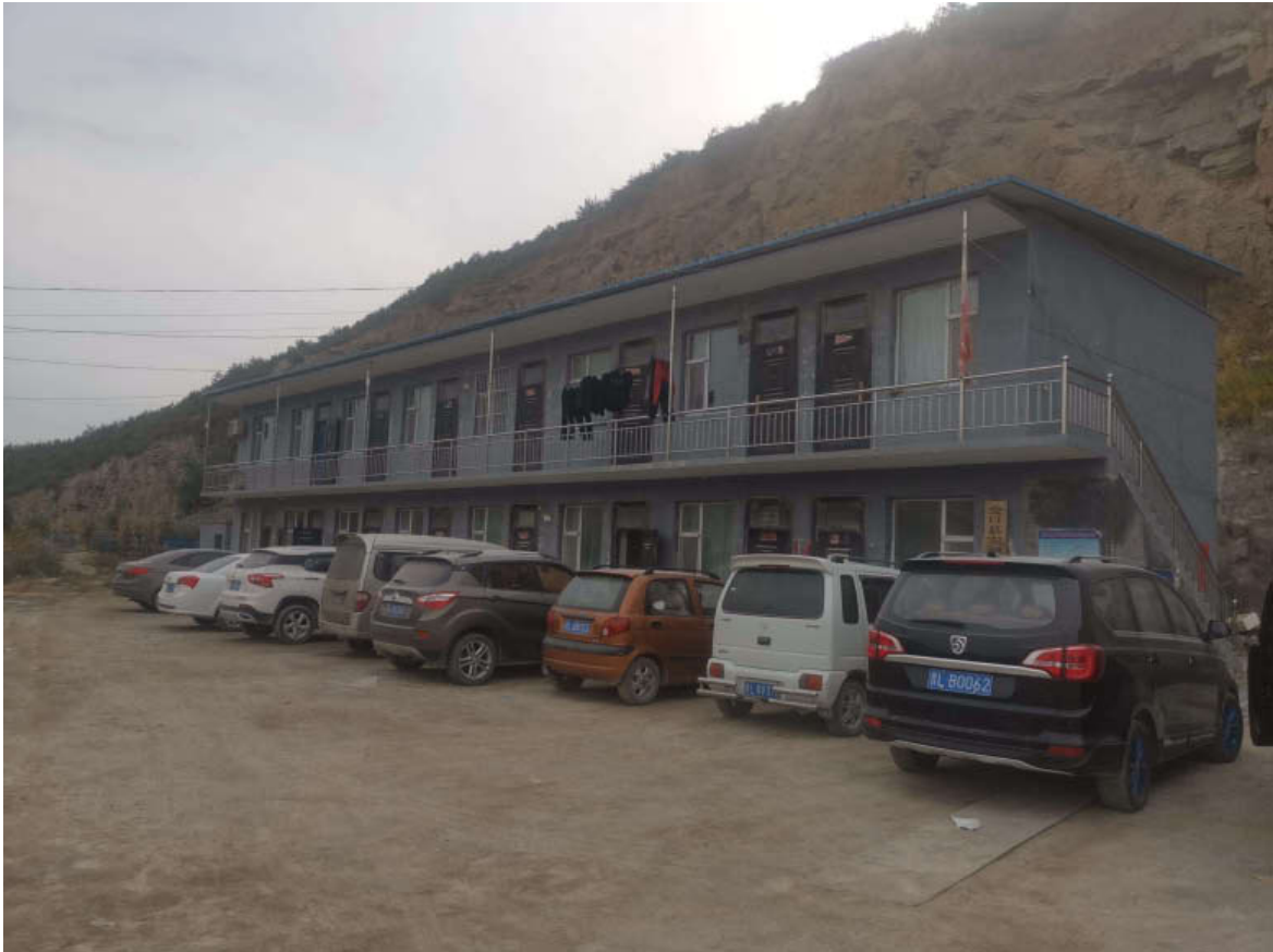
照片 8-2-15 已有办公生活区植被照片
