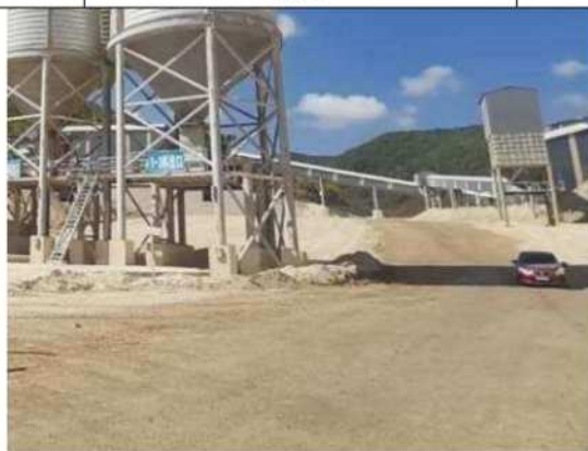
照片 8-2-20 矿山道路现场踏勘图
