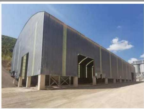
照片 8-2-8 工业场地-产品堆放区
