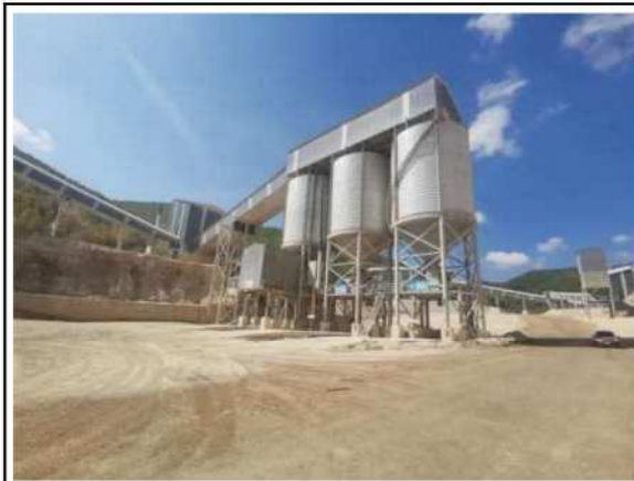
照片 8-2-7 工业场地-碎料加工场
