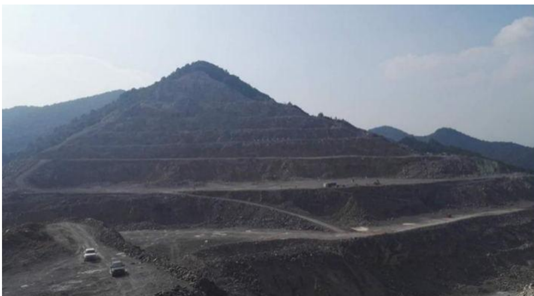
照片 5-2-1 不稳定边坡 XP1（镜向南）
