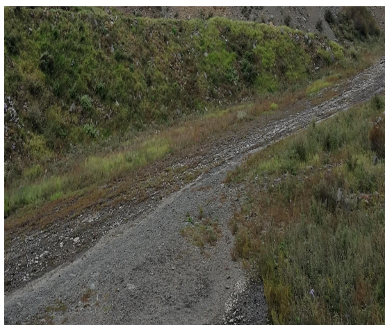
照片 8-2-9 现有道路植被照片
