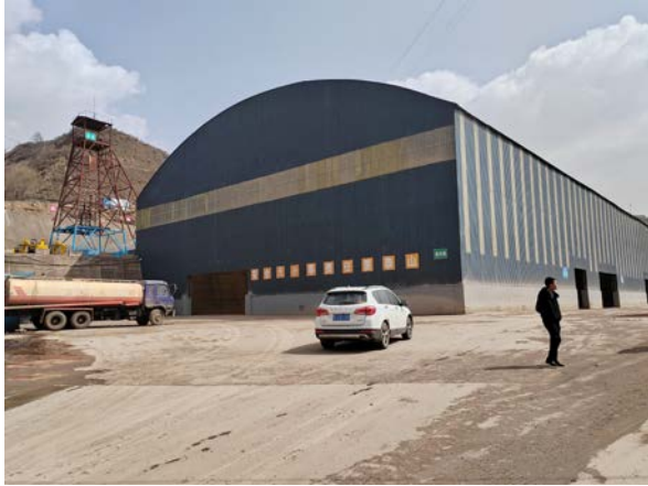
照片 8-2-35 封闭式储料棚
