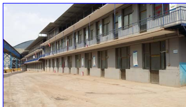
照片 8-2-20 宿舍区地形地貌景观(镜向 W)
