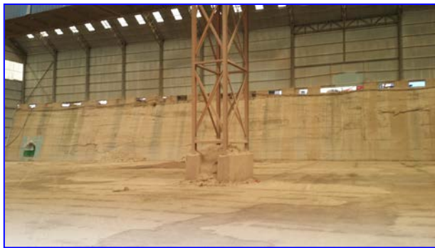
照片 8-2-6 XP 2 已治理边坡 (镜向 NNW)
