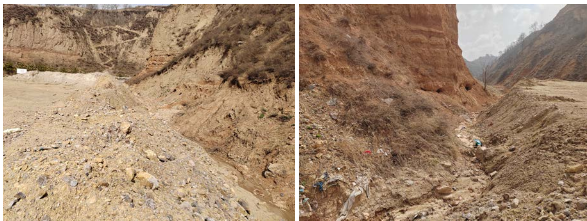
照片 8-2-32 废渣场及留设排水沟
