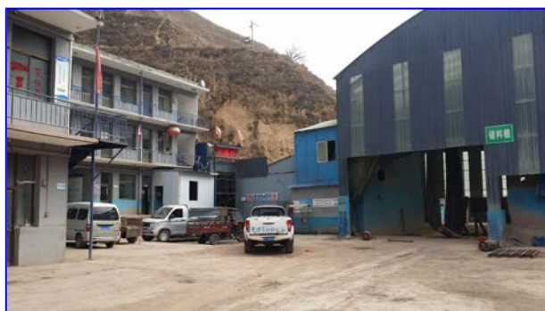
照片 8-2-19 主井、办公、储料场景观(镜向 NE)
