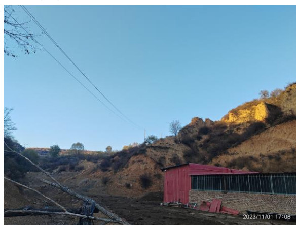
照片 8-2-13 原主井井口处现状
