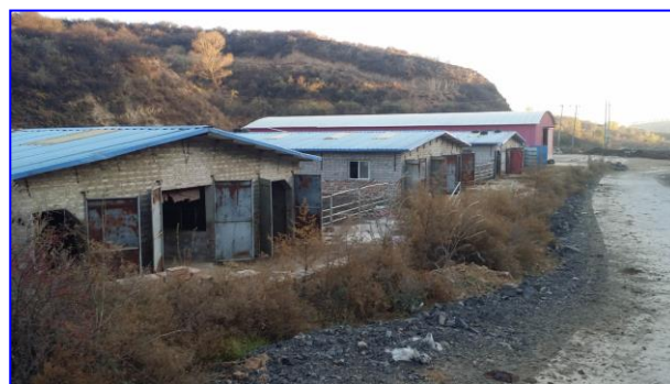
照片 8-2-10 废弃场地地貌景观(镜向 SE)
