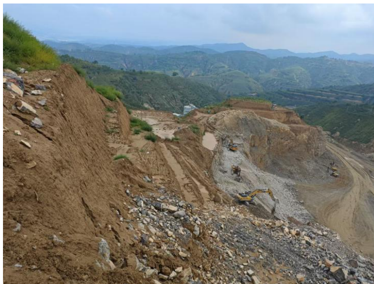
照片 8-2-1 不稳定边坡 BP1
