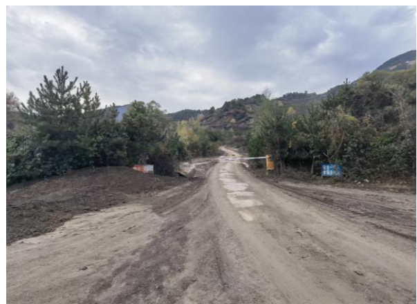
照片 8-8 矿山道路(镜向南)
