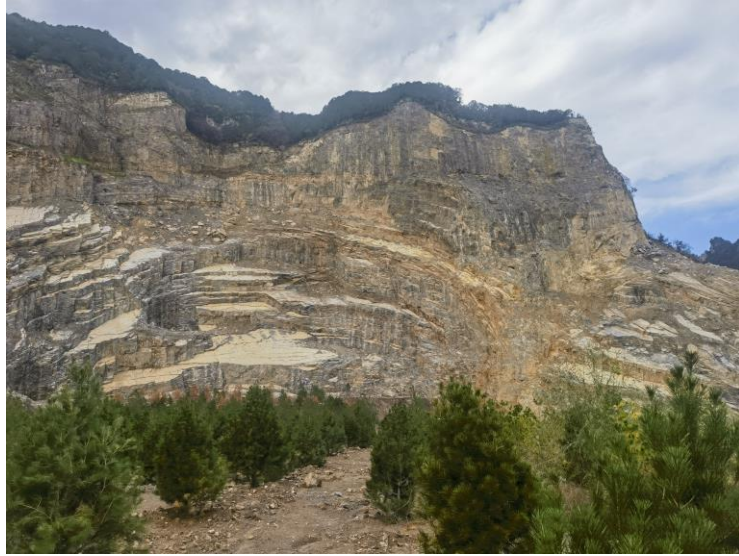
照片 8-1 旧采场 XP1 边坡(镜向北西)
