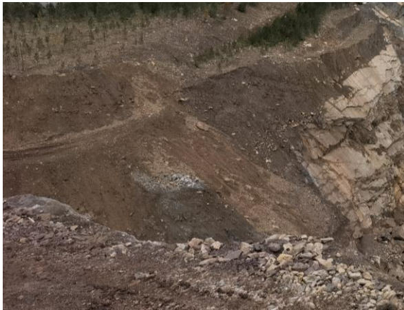
照片 8-10 已有露天采场堆土区
