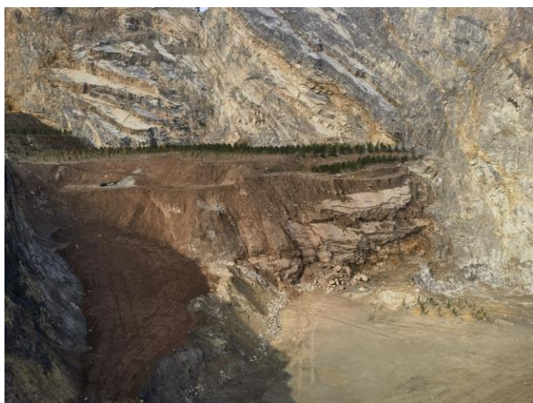
照片 8-12 旧采场现状
