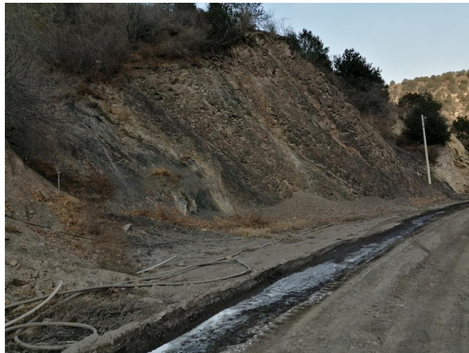
照片 9 矿山道路生态破坏照片
