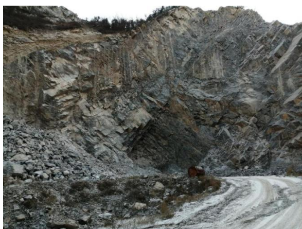
照片 2 BW1 边坡照片
