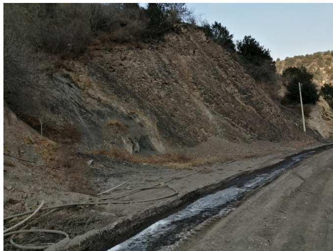
照片 1 矿山道路边坡照片
