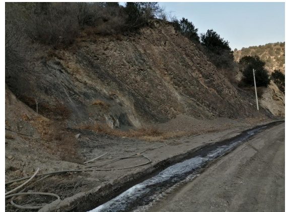
照片 7-2-2 已建矿山道路
