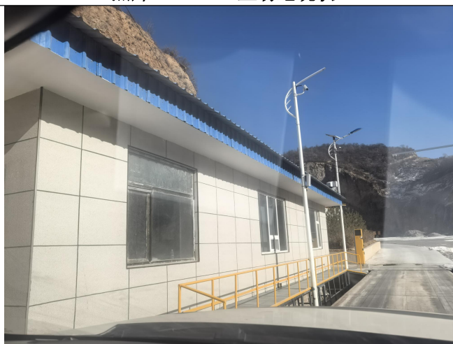
照片 8-2-18 工业场地现状 4
