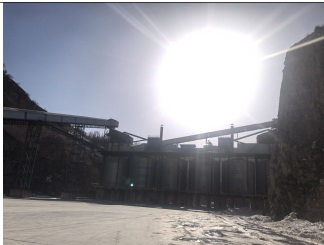
照片 8-2-16 工业场地现状 2
