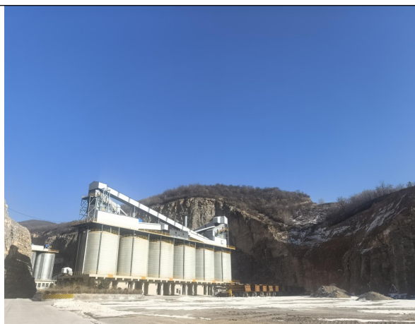
照片 8-2-9 工业场地现状
