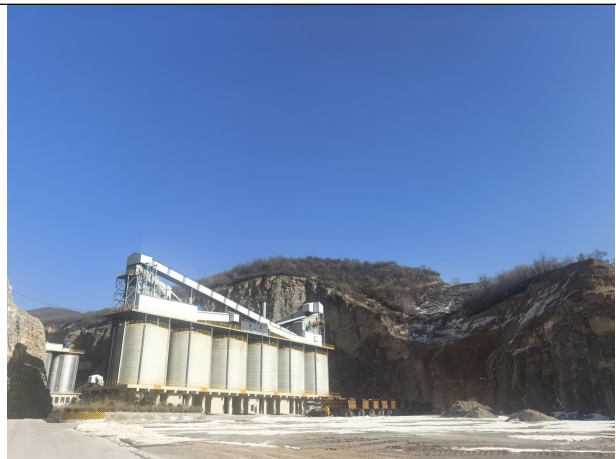
照片 8-2-2 现工业场地现状
