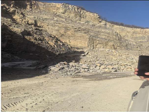
照片 8-2-24 原泰和建材厂已有采坑现状
