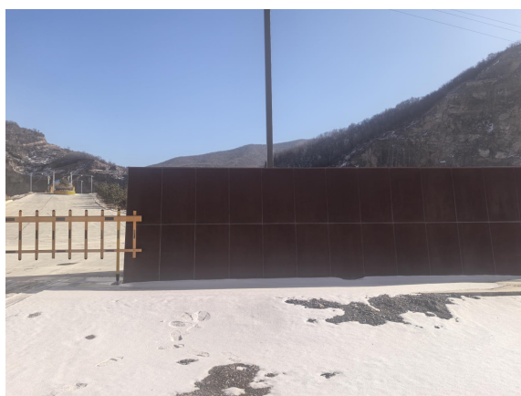
照片 8-2-17 工业场地现状 3
