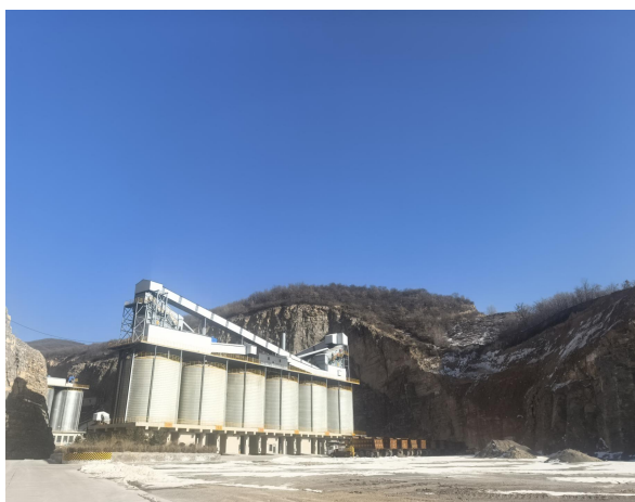
照片 8-2-15 工业场地现状 1
