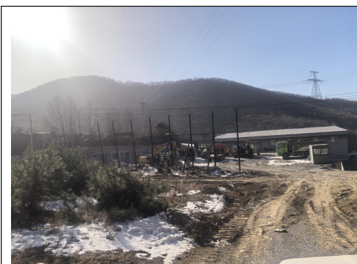
照片 8-2-4 原玉磐石料厂工业场地
