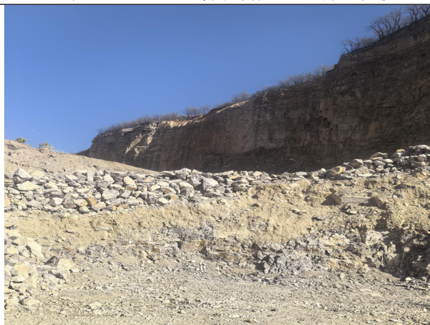
照片 8-2-12 废弃采矿用地现状
