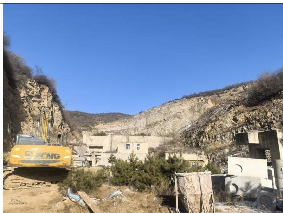
照片 8-2-20 原玉磐石料厂工业场地 2
