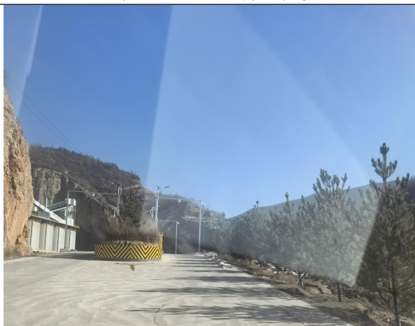
照片 8-2-11 矿区道路现状
