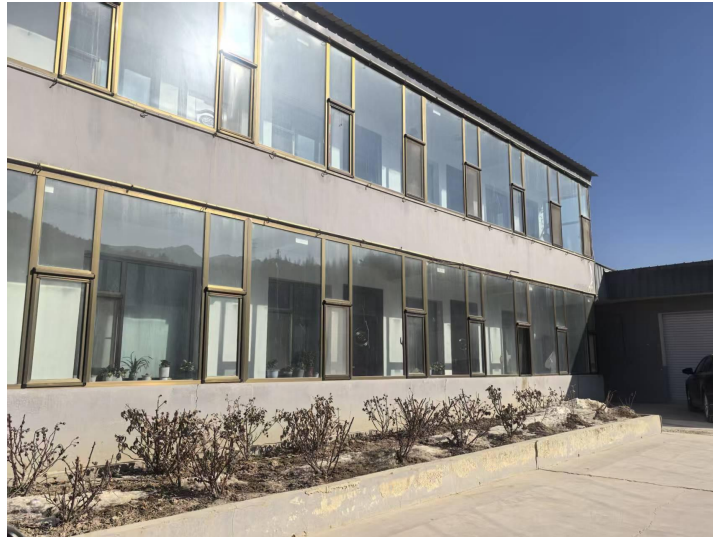
照片 8-2-2 工业场地现状
