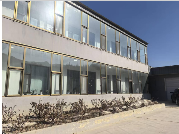
照片 8-2-4 工业场地现状
