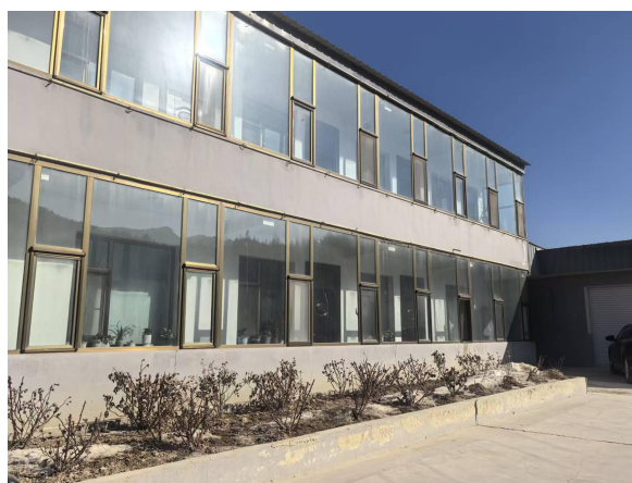
照片 2-1-1 工业场地现状
