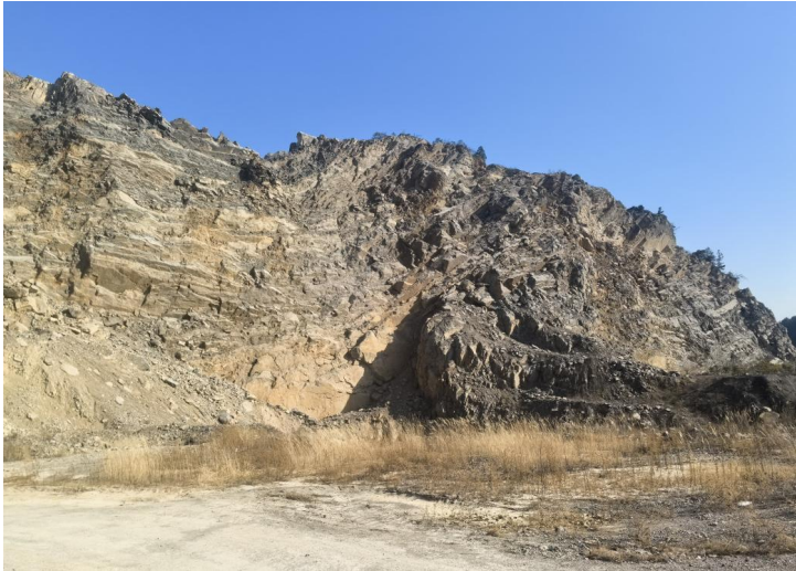
照片 8-2-7 BW6 不稳定边坡照片
