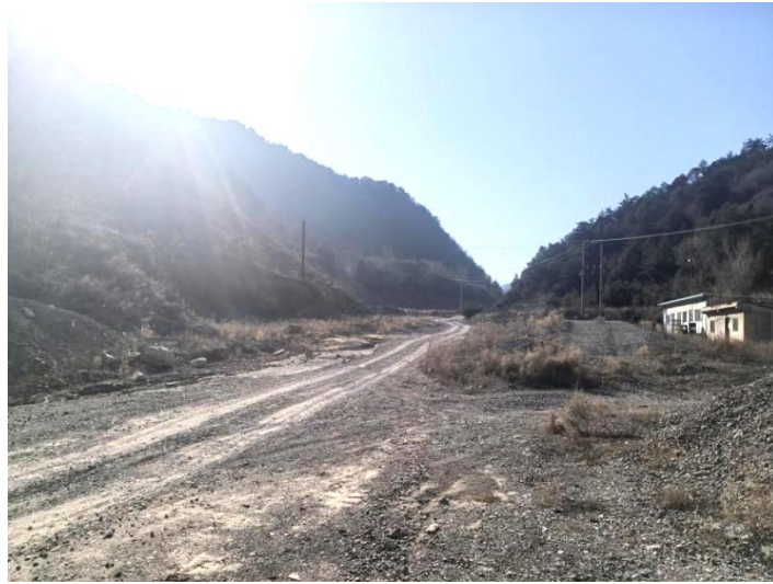
照片 8-2-11 矿山道路边坡照片
