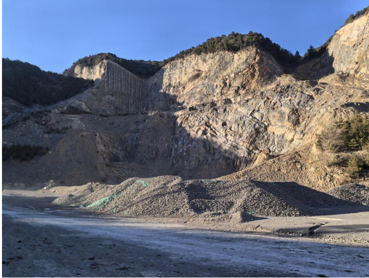
照片 8-2-2 BW2 不稳定边坡照片
