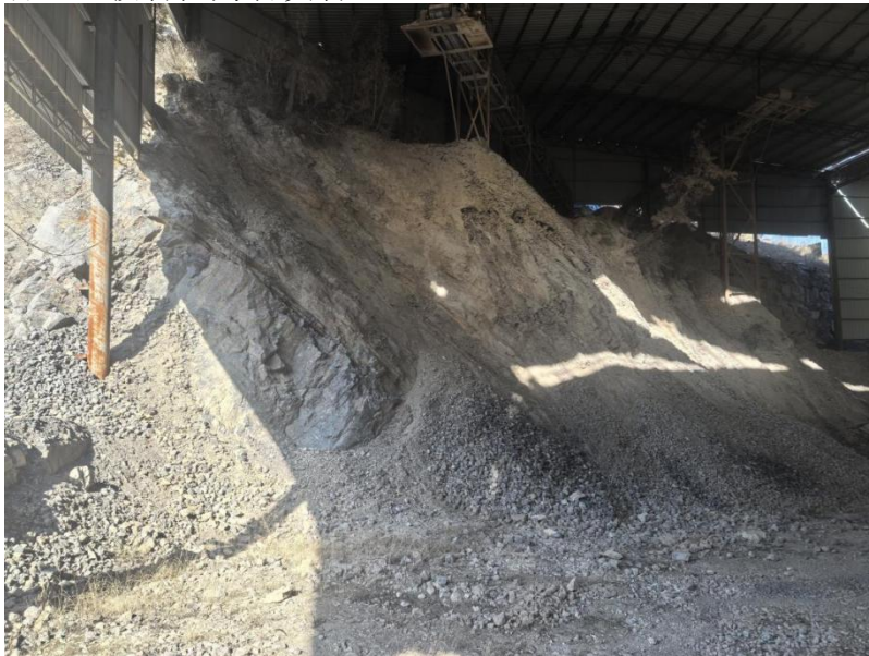
照片 3-1-5 废弃工业场地 2 挖方边坡照片
