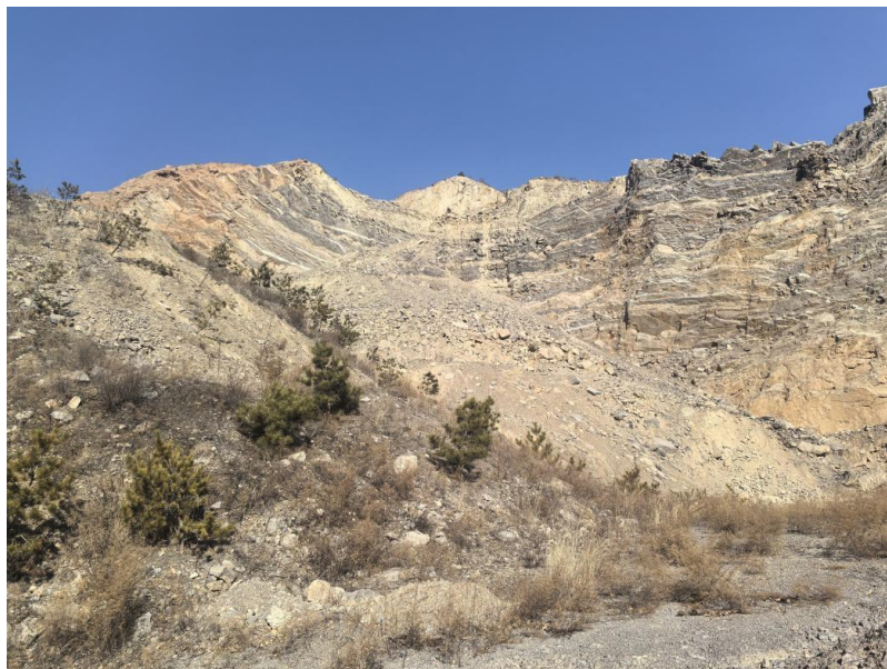
照片 3-1-7 废弃工业场地 4 边坡照片
