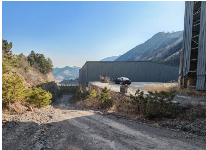
照片 8-2-10 工业场地填方边坡照片
