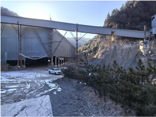
照片 3-1-2 工业场地挖方边坡照片
