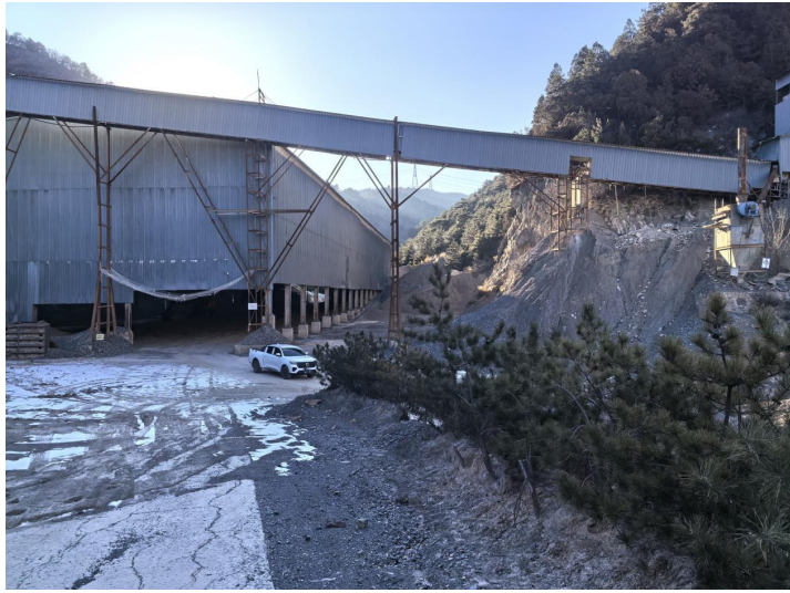
照片 8-2-9 工业场地挖方边坡照片
