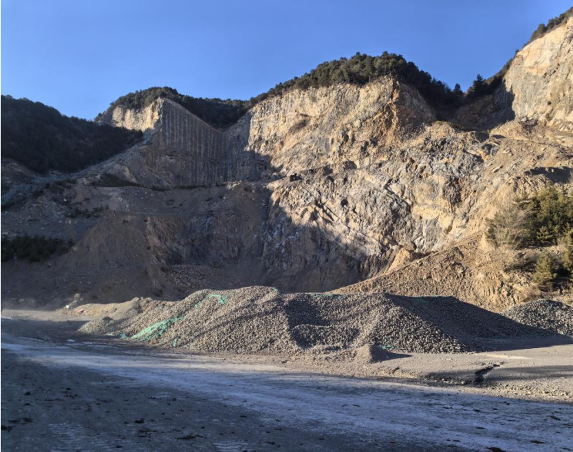
照片 3-1-1 原露天采场边坡照片
