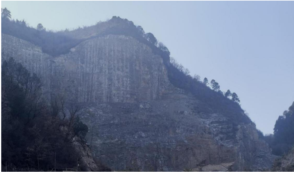
照片 3-1-4 废弃工业场地 1 边坡照片
