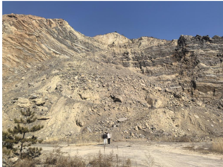
照片 8-2-3 BW3 不稳定边坡照片
