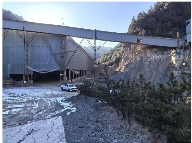
照片 2-1-11 拟建工业场地挖方边坡照片
