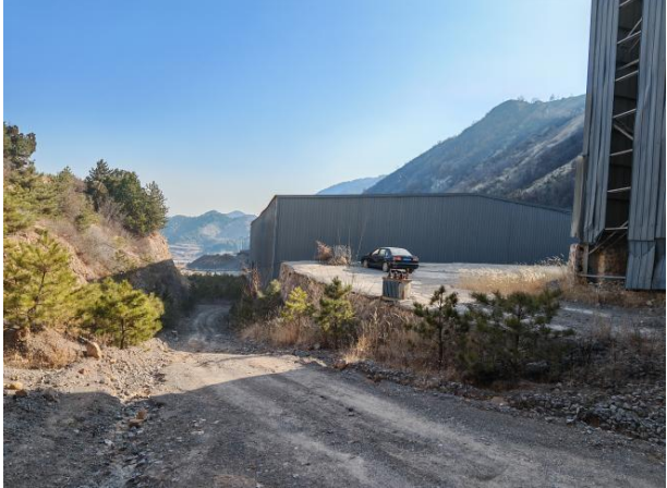
照片 3-1-3 工业场地填方边坡照片
