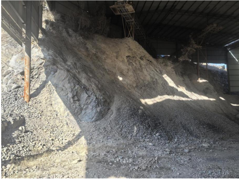
照片 2-1-4 废弃工业场地 2 挖方边坡照片
