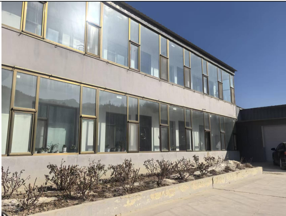
照片 8-2-4 工业场地现状
