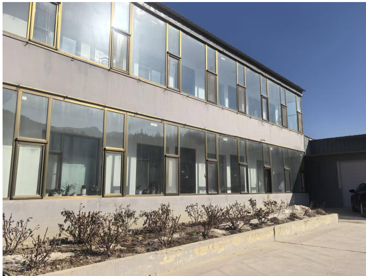
照片 8-2-2 工业场地现状
