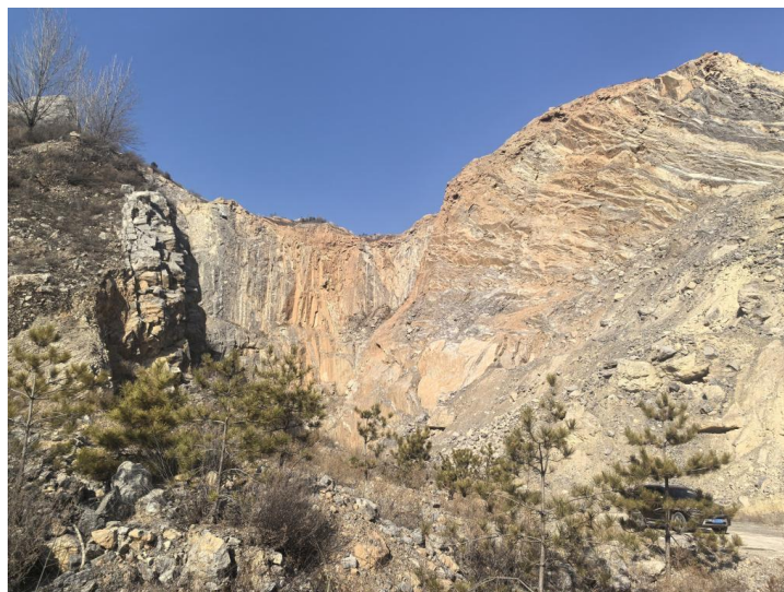
照片 8-2-5 BW4 不稳定边坡照片
