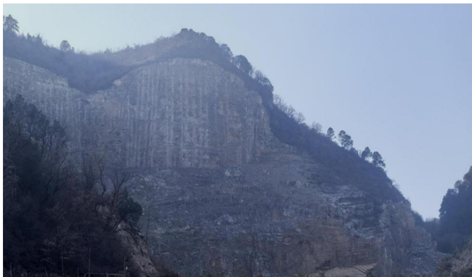
照片 3-1-4 废弃工业场地 1 边坡照片
