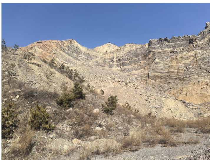
照片 8-2-6 BW5 不稳定边坡照片
