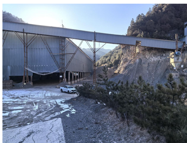
照片 2-1-11 拟建工业场地挖方边坡照片
