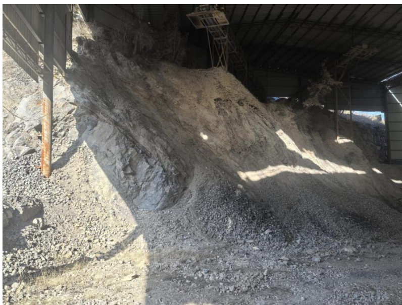
照片 2-1-4 废弃工业场地 2 挖方边坡照片
