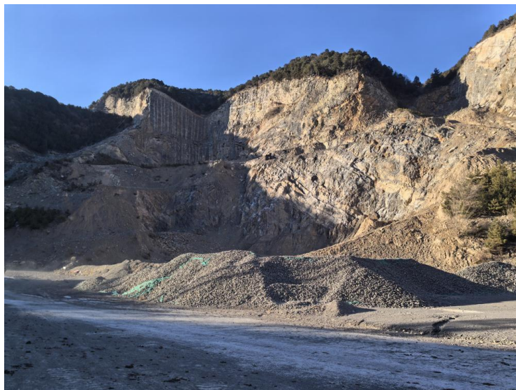
照片 8-2-2 BW2 不稳定边坡照片
