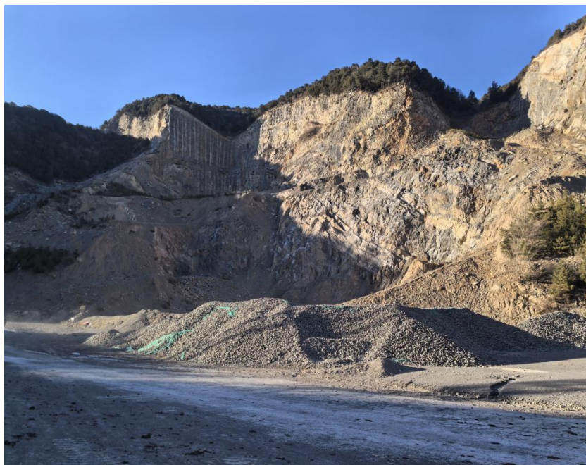
照片 3-1-1 原露天采场边坡照片
