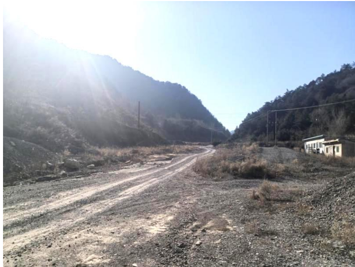
照片 8-2-11 矿山道路边坡照片
