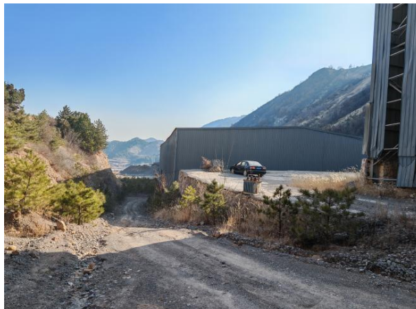
照片 3-1-3 工业场地填方边坡照片
