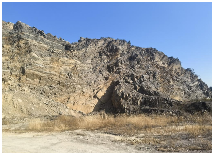
照片 8-2-7 BW6 不稳定边坡照片
