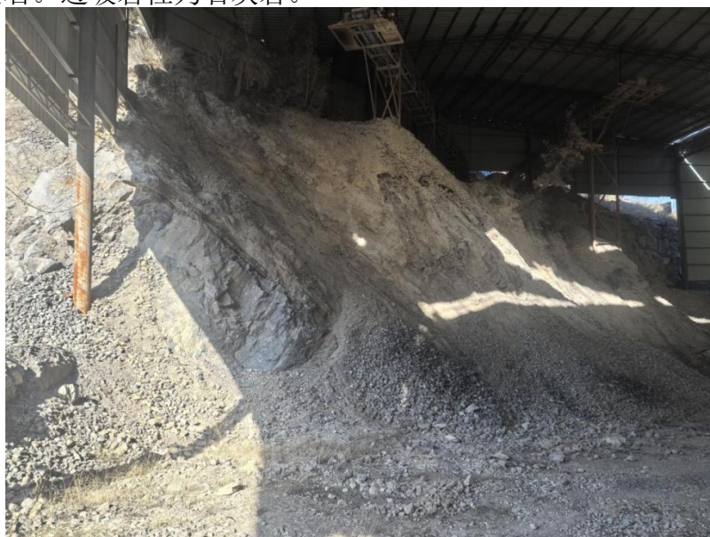
照片 3-1-5 废弃工业场地 2 挖方边坡照片
