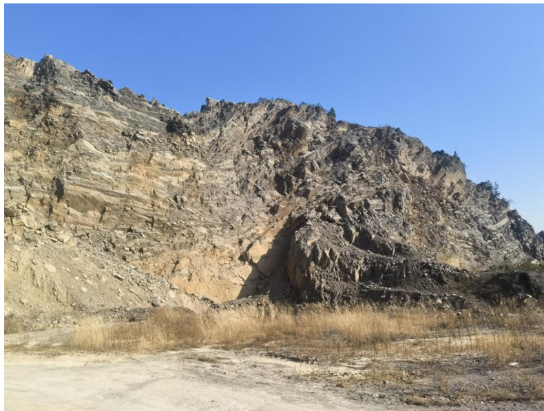
照片 3-1-8 废弃工业场地 5 边坡照片
