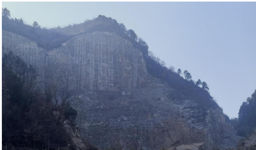
照片 8-2-1 BW1 不稳定边坡照片
